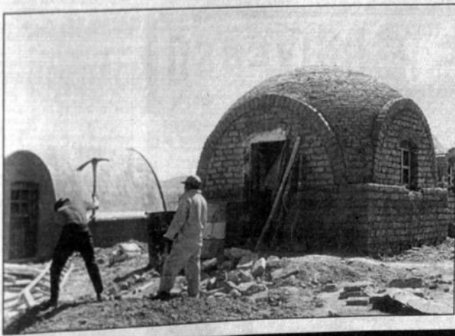
Cúpula con adobes. Construcción en Lahuachaca (provincia Aroma de La Paz).
