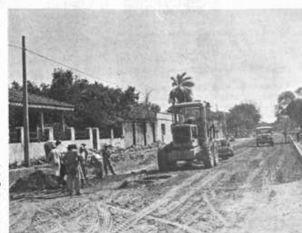
Un grupo de obreros prepara la capa-base para proceder posteriormente al enlosetado de la calle "Libertad" en el extremo Norte de la ciudad. Palatinamente, con la pavimentación de las calzadas de esta capital, un desapareciendo los arenales y charcos de agua. (Foto NIKKA).
