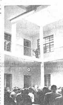
En la fotografía se observa un parte del interior del edificio remodelado de la Oficina Central de Telégrafos, entregado ayer por el Ministro de Obras Públicas.
