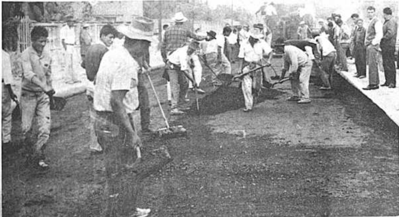
Capa de imprimación en la avenida Aniceto Arce. Cien trabajadores en acción.
