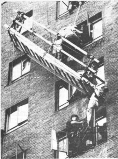
Los limpiadores de ventanas, sostenidas por sus cinturones de seguridad a unos pocos por encima del suelo, son salvados pocos minutos después de que el edificio de la sede de la base resultó, en este edificio de Manhattan. (AP Wirephoto)
