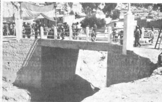
El puente de Cotahuma en la zona de Tembladerani construido con el esfuerzo de la comunidad y el programa combinado de Acción Comunal, Acción Cívica y USAID/B.
