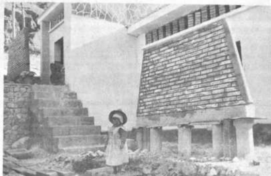
Mingitorio de estructura arquitectónica moderna construido por Acción Comunal y entregado al servicio público en Villa Sagrado Corazón de Jesús.
