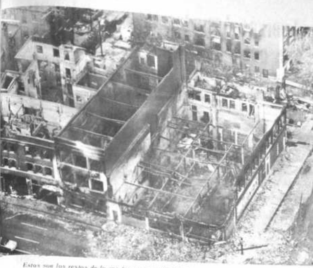
Estos son los restos de lo que fue una casa de departamentos y oficinas comerciales. Un incendio provocado durante los actos de violencia en Detroit redujo a escombros el edificio ocasionando pérdidas estimadas en millones de dólares.
