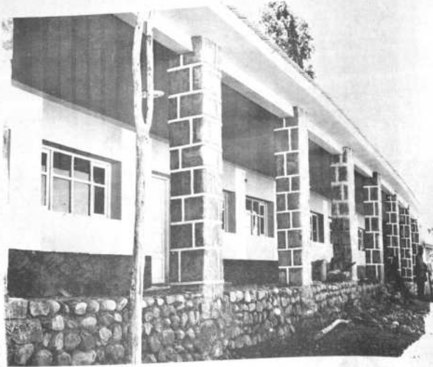
En el departamento de La Paz, una de las mejores obras construidas por los campesinos, al presente, con el máximo de su capacidad, constituirá el colegio secundario de Huatajata, uno de cuyos pabellones aparece en la fotografía.
