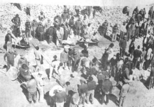
Un campo de trabajo de Acción Comunal en Uta, periferia de la zona de El Tejar donde se construye un tanque de almacenamiento de agua potable con el concurso del vecindario de las zonas populares.
