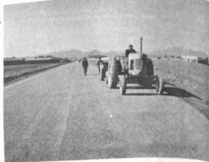
Fase de compactación del camino asfaltado de acceso al Aeropuerto Internacional de El Alto, con el empleo de equipo especial del Servicio Nacional de Caminos.
