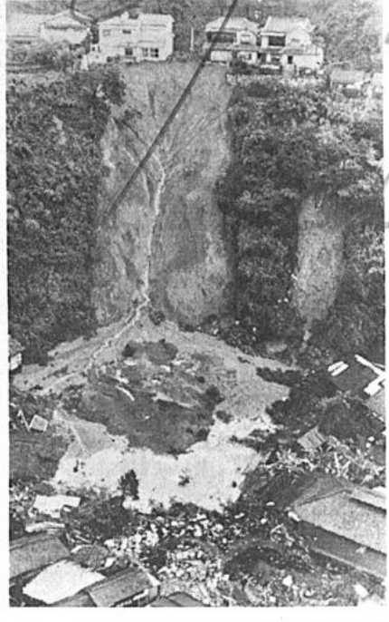
Casas recientemente construidas bajo un acantilado en Nagasaki-Ku, Kobe, Japón, son devastadas, por un alud producido el 9 de julio, a consecuencia del tifón Billie. La sección blanca señala el camino del alud. (AP Wirephoto).
