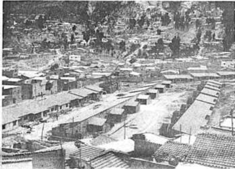
Mediante el sistema de "autoconstrucción", CONAVI concluirá en breve 46 casas en la zona de Tembladerani (Sopocachi Alto). En el grabado se observa una parte de las viviendas en cuyo programa participan diversos sectores laborales.
