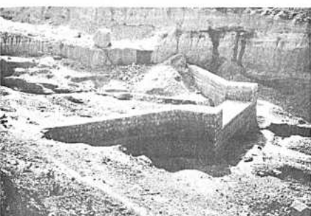
Sobre el riachuelo ChuquiagUILlo se ha construido una serie de muros de contención, vertederos y muros de encause.
