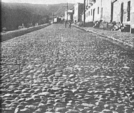
Adoquinado de tercera clase colocado en la Avenida Chacaltaya populoso barrio fabril en constante crecimiento.
