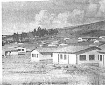
123 viviendas se han construido en la región de Sucre, con destino a petroleros estatales de la República. Hasta el momento se han adjudicado y prosiguen los trámites para completar el programa de "Pokonas" del mismo distrito, se han completado las adjudicaciones. En la fotografía se ven las casas de los petroleros estatales.
