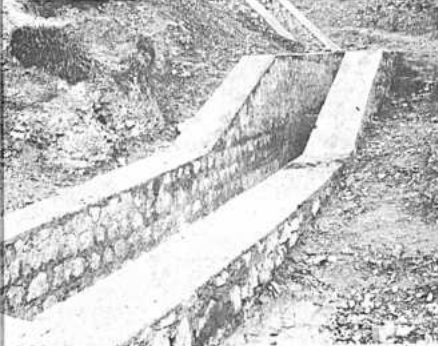
Una de las canalizaciones abiertas de las muchas que se han construido en los 58 riachuelos que cruzan la ciudad.
