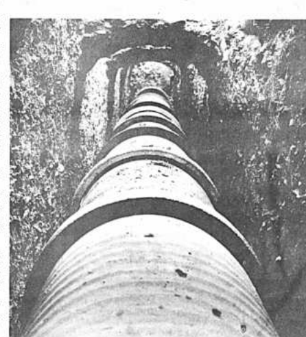
Esta es una de las varias obras de alcantarillado realizadas en diferentes zonas de la ciudad en el curso del primer semestre de este año.
