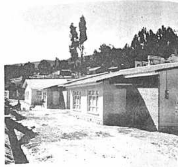
Una de las ultimas urbanizaciones concluidas es la de Bella Vista, Obrajes. Aquí se han adjudicado 46 viviendas a periodistas de La Paz, que están actualmente ocupadas en su totalidad. En el grabado se observa la fachada principal de algunas casas, pectivas escaleras de acceso.
