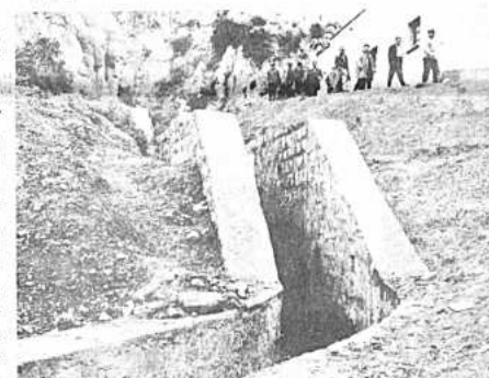
Canalización del riachuelo "El Palvorin" la zona Tejada Sorzano, Miraflores.
