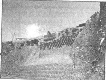
Puente San Jorge que aún no fue terminado.
