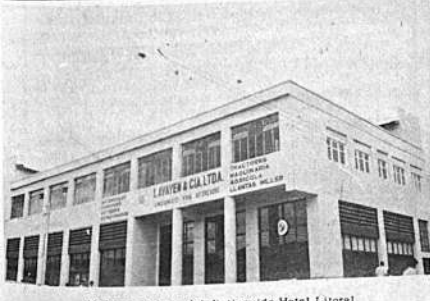
Moderno edificio del distinguido Hotel Litoral
