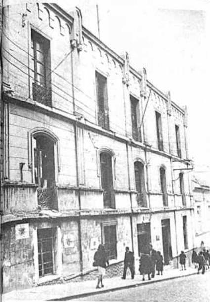
El viejo edificio donde funciona la Oficina principal de Telégrafos de La Paz. Aunque está siendo reparado por dentro, no podrá satisfacer las necesidades reales de tan importante servicio.
