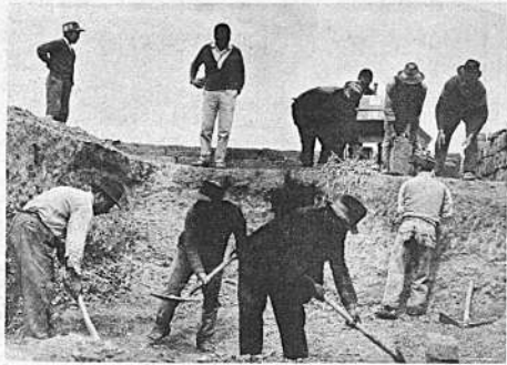
En plena labor de excavación para el futuro silo, los campesinos de la cooperativa de "Exaltación Ltda" trabajan activamente en la preparación de un silo para "esconder" el forraje para la época de invierno.
