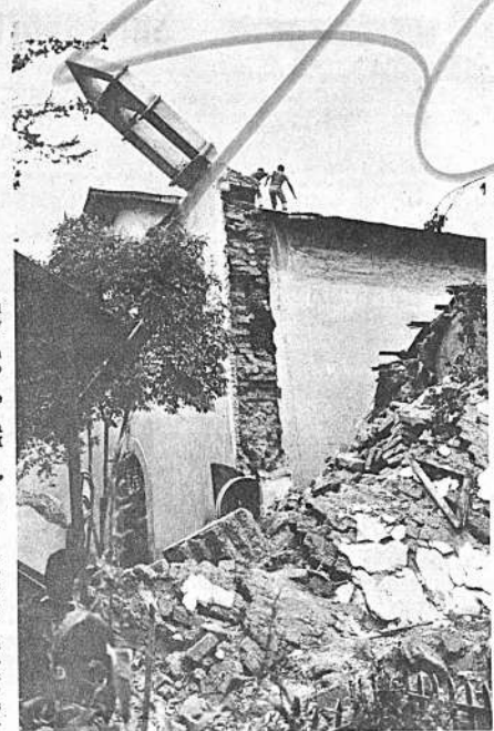
Una de las torres de la cárcel y una pared de ocho metros de largo por cinco de alto se desplomaron ayer en el interior del Panóptico. No hubo desgracias personales; sin embargo, quedaron afectados las secciones "Alamos" y "Preferencia" de la penitenciaría. El estado ruinoso del edificio carcelario significa peligro para la seguridad de los reclusos.
