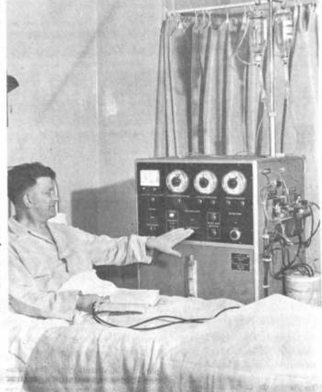
Un aparato que dará nuevas esperanzas a las personas con rinitis defectuosas acaba de perfeccionarse en Inglaterra. Se lo conoce como la unidad de tratamiento automático para un solo paciente y el equipo electrónico que lo compone está diseñado para purificar la corriente sanguínea del paciente dentro de la comodidad de su propia casa, usado en conjunción con un riñón artificial. El Ministerio de Salud de la Gran Bretaña ha pedido cincuenta de estas unidades a prueba de fallas y de bajo costo.
