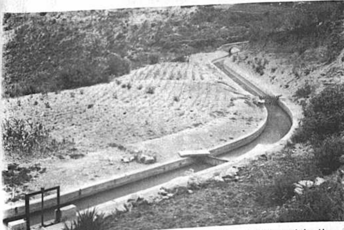
El mantenimiento del acueducto que conduce agua potable para el consumo de la población, es motivo de constante preocupación de la Alcaldía de Sucre. En el trabajo desahogado, se emplean más de 100 trabajadores.
