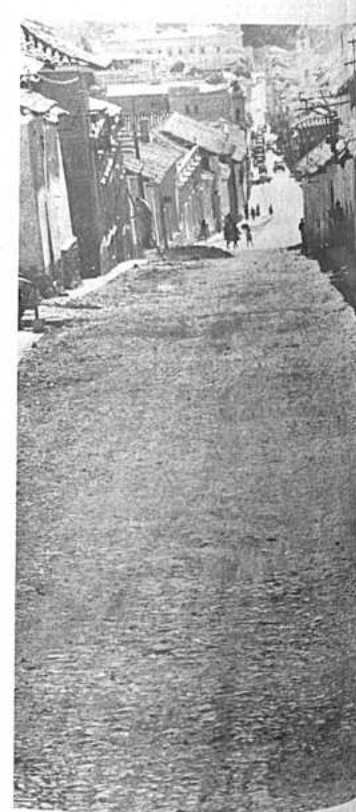
La Calle Almirante Grau es otra de las arterias beneficiadas con los trabajos de pavimentación.
