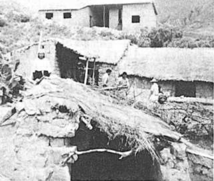
El Comité de Vivienda de Curzani usa los servicios de VIPO. En la foto se pueden distinguir la casa antigua del socio Guillermo Méndez, y su nueva casa. Se desarrollará una planificación para las construcciones de vivienda.
