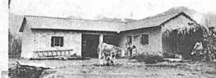
La casa de Hilarión Guzmán en Chapuisuyo. VIPO coopera en la construcción. En Chapuisuyo se inauguró dentro de seis meses un conjunto de doce casas. Se intentó formar una Caja de Ahorro y Préstamos para Vivienda Rural.
