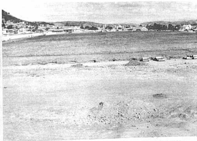
En este terreno, donde ya se ha sembrado el raigrass, se construye el estadio "Patria", máxima aspiración de la juventud capitalina.
