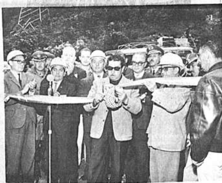
El Alcalde interino de La Paz, Dr. José Córdova, corta la cinta tricolor inaugurando así los trabajos de la nueva Planta Hidroeléctrica de Harca.
