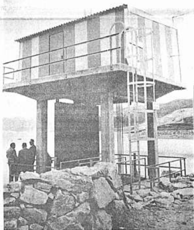
Vista de la torre de control de compuertas en la presa de Corani.
