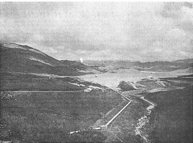
Embalse de las aguas de Corani y tubería de presión destinada a la alimentación de la planta de Pampa Tambo. Allí donde hasta hace un tiempo no había sino una agreste campiña, hay ahora un lago inmenso que, de forma conca, abre grandes posibilidades a la actividad pesquera de una crecida masa campesina que vive en las zonas aledañas, al mismo tiempo de constituir lugar de gran atractivo turístico.
