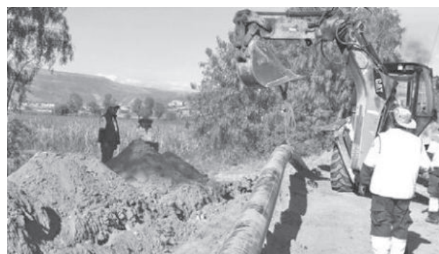
Los trabajos del “Ramal Sur”, en la Maica. SEMAPA
