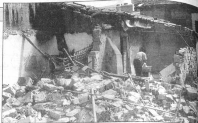
Walter Prado, el dueño inició la demolición de la embajada.
