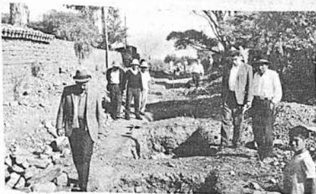
Trabajos de excavación para la colocación de la tubería aductora de Tolapucru a Calaca que tendrá 6.500 metros de extensión.
