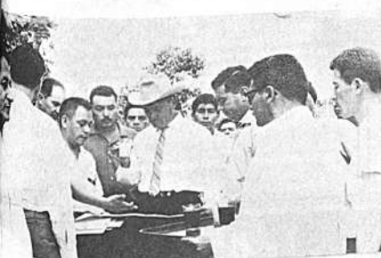
El Presidente Barrientos gusta de un vaso de refresco, mientras observa un plano, sobre el lugar, de la estructura del pozo petrolífero "El Tigre", que le enseñan los ingenieros de Y.P.F.B.
