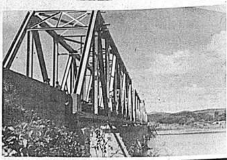
Puente Florida del FF.CC. Yacuiba-Santa Cruz, que recientemente fue inaugurado por el Ministro de O.P.P. conjuntamente con los ejecutivos de la Comisión Mixta Ferroviaria Argentina-Boliviana. Dicho puente metálico tiene una longitud de 154,80 mts.
