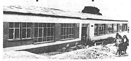
La directiva de la Asociación de Damas Voluntarias de Ayuda al Hospital de Broncopulmonares recibió ayer el primer pabellón de ese nosocomio que está siendo construido en terrenos ubicados en el Hospital General de Miraflores.
