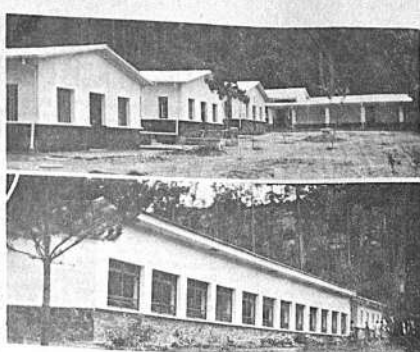
ARRIBA.- Los dormitorios de la Normal Rural de Espada. ABAJO.- El pabellón que corresponde a los comedores. Es una obra que contribuirá a la educación campesina.
