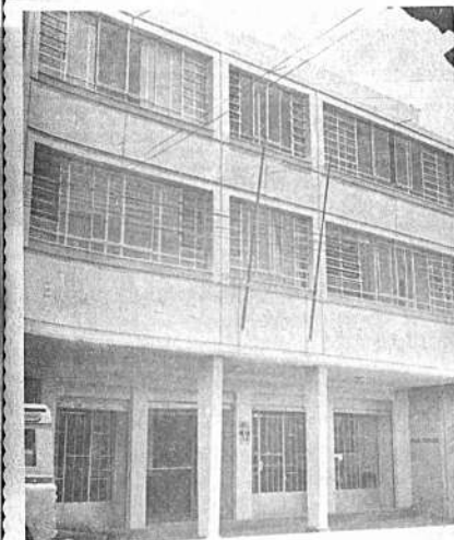
Fachada del edificio del Banco Do Brasil situado sobre la calle Ayacucho, a media cuadra de la plaza principal.
