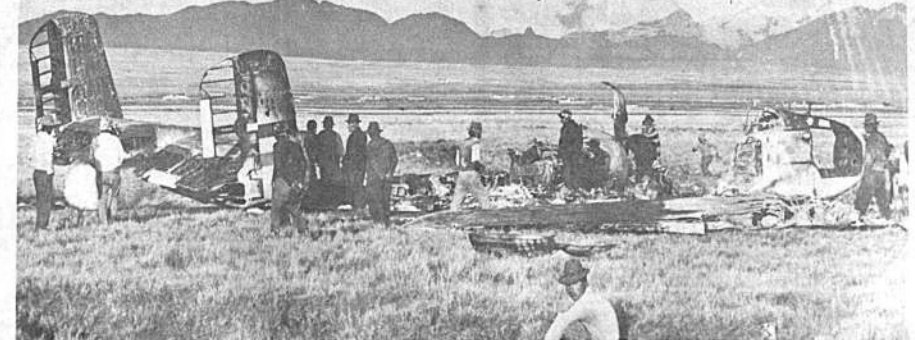
Un aspecto de la aeronave consumida por el fuego: el fuselaje quedó convertido en cenizas; el ala derecha, desprendida del avión, yace a pocos metros completamente deshecho; el motor del mismo lado, al desprenderse por el impacto del "panzazo", se proyectó a más de doscientos metros, "rebotando y rodando como una pelota" al decir de algunos testigos. Una de las ruedas se encontraba a unos setenta metros del avión. Una franja de unos 250 metros, por donde rodó el avión, aparece con la hierba chamuscada.
