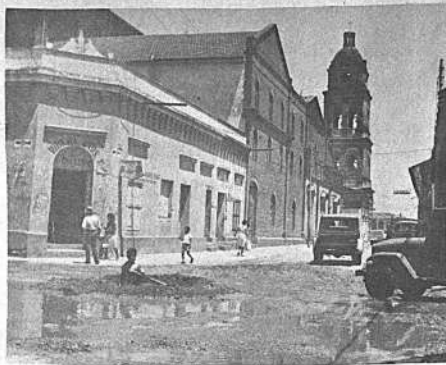
Santa Cruz, 9 PRESENCIA.- Entre los problemas urbanos que enfrenta esta ciudad, sobresalen los riachuelos que se forman en algunas de las esquinas, obstaculizando el paso de los peatones. Con las lluvias, lo mayor parte de las calles se convierten en verdaderos bariles, ofreciendo un aspecto que atenta contra el urbanismo. Con los proyectos de adecuación cuyos trabajos han comenzado en la plaza principal, serán superados esos problemas.
