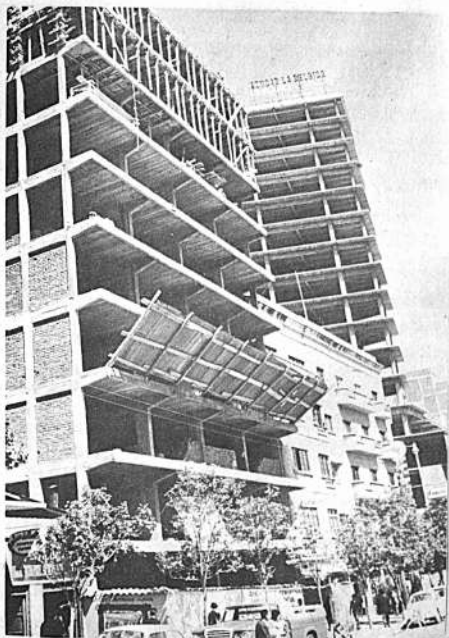
El edificio "Bolivar" que se levanta vertiginosamente en la avenida Mariscal Santa Cruz. Está destinado a tiendas comerciales y oficinas modernas. Al fondo, se observa la obra gruesa del edificio de 16 pisos, paralizado desde 1960.
