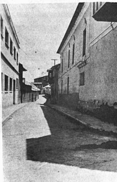
La Junta Departamental de Obras Públicas de Potosí ha demostrado preocupación por las necesidades de la ciudad al que resueltamente ha encarado su solución realizando obras de positivo valor. El gráfico muestra el pavimentado de la calle "S. Chacón" que los días viernes reúne gran cantidad de peregrinos que van ante el Señor Justo Juez.
