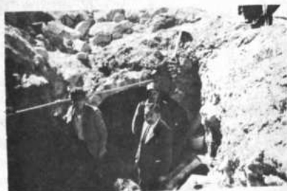
Canalización de la calle "La Paz", zona sur, efectuado por la Junta de Obras Públicas.
