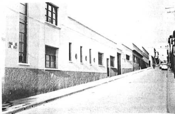
Calle "Tomás Frías" cuyo pavimentado con piedra "ala de mosca" fue recientemente entregado por la Junta de Obras Públicas de Potosí.
