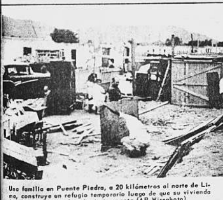
Una familia en Puente Piedra, a 20 kilómetros al norte de Lima, construye un refugio temporario luego de que su vivienda fue destruida por el reciente terremoto (AP Wirephoto).
