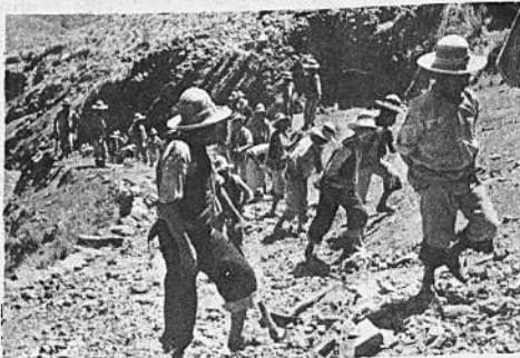
En las cercanías a la comunidad de Tironi los campesinos del lugar trabajan en la apertura de un camino utilizando escasos herramientas rudimentarias. Estos voluntarios precisan la ayuda y el asesoramiento técnico de parte del gobierno. (Foto PRESENCIA)
