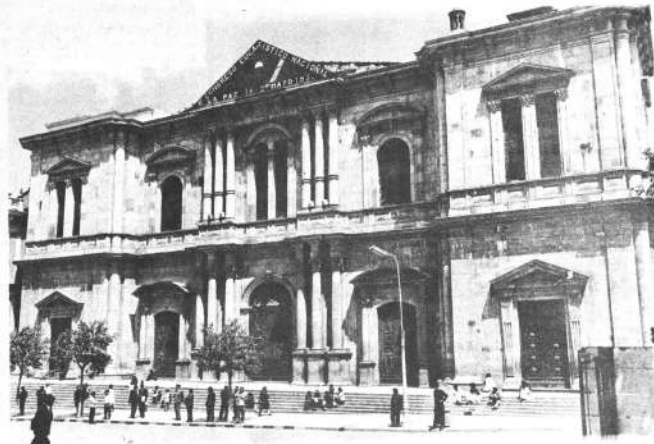
Este es el aspecto actual que ofrece la obra inconclusa. Una catedral chata que le faltan sus dos torres, cuya construcción con hormigón armado con revestimiento de piedra, además de obras complementarias, tendrá un costo de $us. 180.000.
