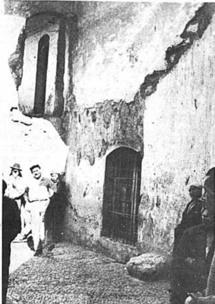
El principal acceso a las diferentes secciones del penal ofrece este estado de ruinas, similar al de otras partes del edificio. Cualquier momento se vendrán abajo las paredes.
