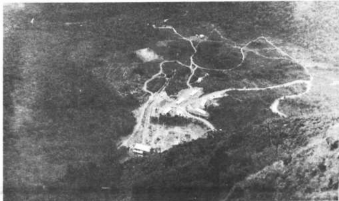
La fotografía ha sido captada desde la parte superior de la represa. Al fondo, la casa de máquinas y las estaciones elevadoras de voltaje. Sirviendo de marco a ese avance humano, las fértiles tierras de la cabecera del Chapare. De allí saldrá la energía eléctrica de CORANI.
