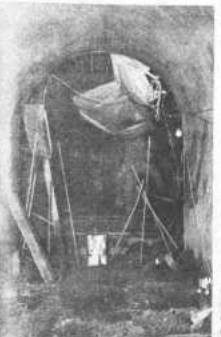
1.133 metros de túnel, atravesando una enorme montaña, ha sido excavado para que por allí atraviese la tubería que llevará el agua que generará la energía eléctrica en la casa de máquinas. El túnel, --parte del mismo en la fotografía-- está completamente revestido de hormigón armado y tiene las medidas de seguridad necesarias para impedir un posible derrumbe.
