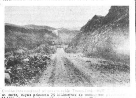
Comiso internacional en construcción Tacna-Jankochupla, en un corte, cuyos primeros 25 kilómetros se encuentran ya en explotación y 13 kilómetros restantes están en exploración y 30 kms. en estudio.
