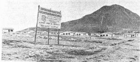
CONAVI, BID y CBF han construido 155 viviendas para los trabajadores petroleros de la refinería Mesa Verde.
