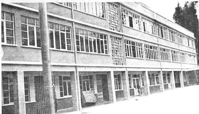
Parte frontal del moderno edificio del Instituto "Villa María", de Obrajes. La obra ha sido realizada a base de esfuerzo propio de la comunidad. "Obra de la Divina Providencia", dicen las religiosas del Buen Pastor. Allí se instruye a una juventud que después contribuirá al desarrollo del país. Allí se enseña a vivir, a amar la existencia...
