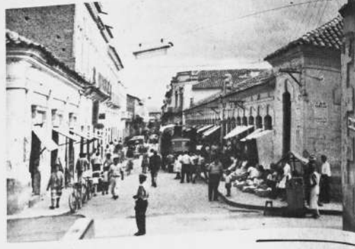
El Mercado Central de Tarija, que aparece a la derecha, está siendo refaccionado por la Alcaldía. La calle sobre la que está edificado el mercado fue pavimentada y dotada, previamente, de riego.
