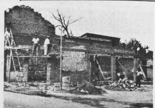
Un moderno mercado de flores está siendo construido y se denominará Mercado "15 de Abril". El gráfico muestra a los obreros en construcción en pleno trabajo.
