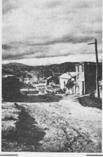
Con muy pocas maquinarias, la Alcaldía tarijeña se esfuerza en hacer obras eficientes. El gráfico muestra una parte de la urbanización de Villa Abaroa. Antes, era una región inhabitable, hoy, gracias al esfuerzo municipal pueden apreciarse diseños de calles y avenidas.
