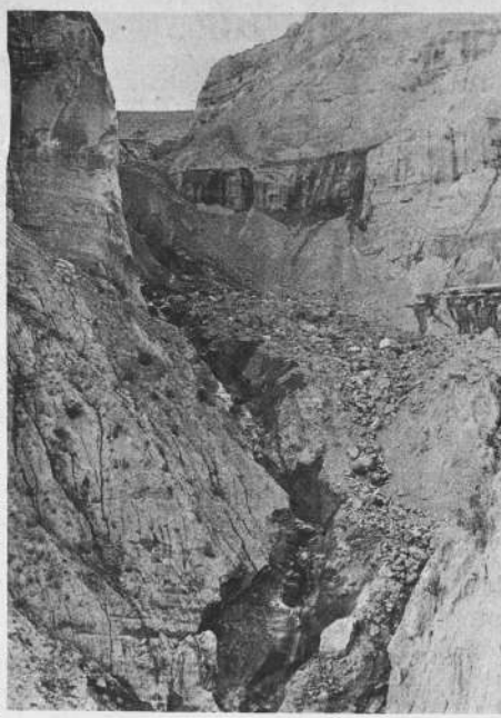
Los pobladores del barrio de Tembladerani viven con el temor de una masa de tierra de dos mil metros cúbicos que amenaza con desplomarse sobre sus viviendas. Las lluvias producen filtraciones de agua que aproximan el desastre. La Alcaldía envió una cuadrilla de hombres que está limpiando el cauce de un pequeño arroyo que baja de esas alturas.
