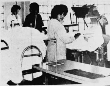
SECCION PLANCHADO.- La Fábrica de Confecciones "Fernández" está dotada de maquinaria moderna. Esta trabajadora hace uso de una máquina automática para planchar los cuellos de camisas.
