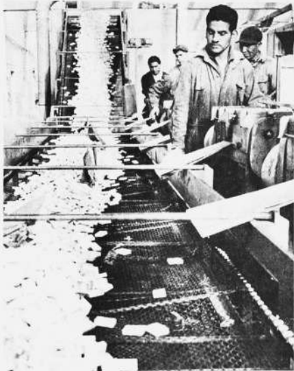
Buena parte del grabado en la Fábrica Nacional de Fósforos está mecanizado. El grabado muestra un aspecto de ese proceso: las cajas internas de fósforos son transportadas a determinado sitio donde se produce el ensamblamiento con la parte cubierta de las cajas de fósforos. Posteriormente, dichas cajas ensambladas son llenadas de fósforos en forma también automática.
