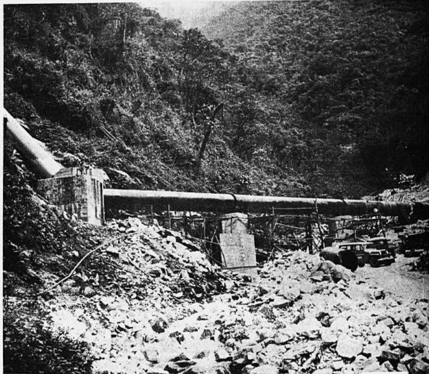
La presente fotografía muestra el montaje de la cañería para el sifón, como puede notar el esfuerzo y precisión.
