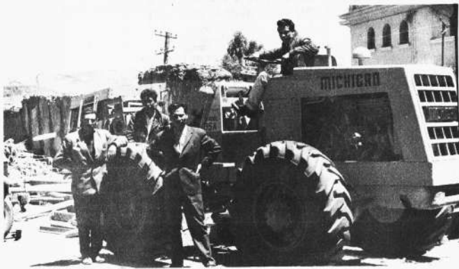
Con el dinamismo impreso a la Junta de Obras Públicas, esta entidad recién adquirió maquinaria pesada para cumplir una labor más efectiva y acelerada. Parte del equipo está en tránsito.
