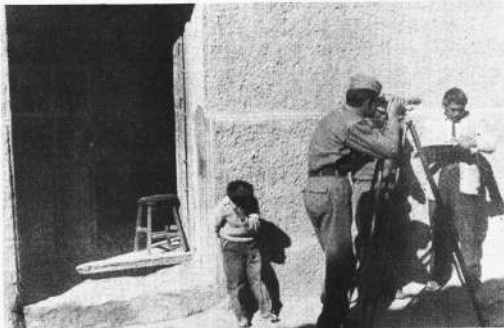
Una brigada de nivelación de primer orden para el control del plano fotogramétrico de la ciudad de Potosí.
