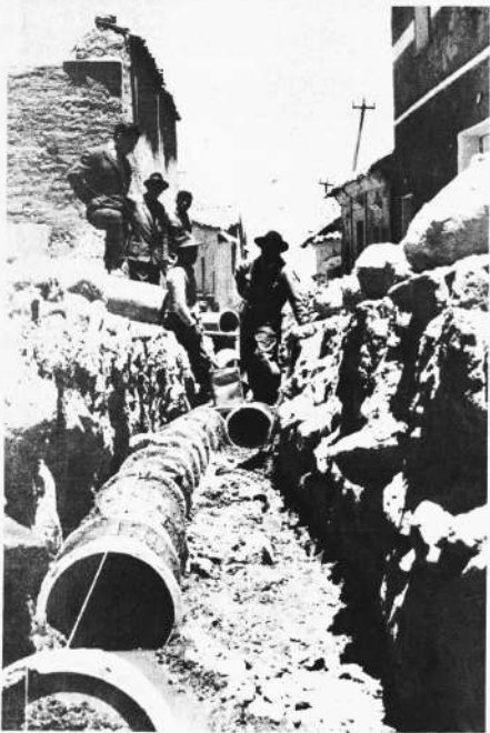
A cargo de la Junta de Obras Públicas se realizan los trabajos de alcantarillado en las zonas suburbanas. La foto corresponde a las obras que se realizan en la calle Surco.
