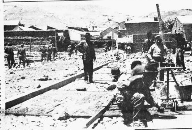
Un mercado zonal ha sido construido junto a la Av. Camacho destinado a los comerciantes minoristas. Cooperan en los trabajos conscriptos del regimiento acantonado en Potosí.
