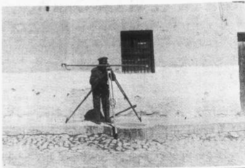
El Instituto Geográfico Militar tiene a su cargo el levantamiento topográfico y catastral de la ciudad. En la foto, medición de base con mira horizontal. Corresponde a la etapa pre-catastral.
