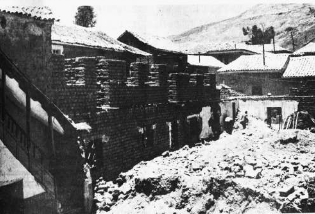
El Colegio "Juan Manuel Calero" que cuenta con más de quinientos alumnos precisa mayor espacio para que el profesorado pueda cumplir su misión educativa. La Junta de Obras Públicas hizo bien en atender esas necesidades al emprender trabajos de ampliación del establecimiento, como los que aparecen en el grabado.
