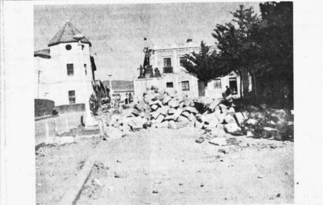
Parte de los trabajos de refacción en la Avenida principal que conduce a la Estación Central.
