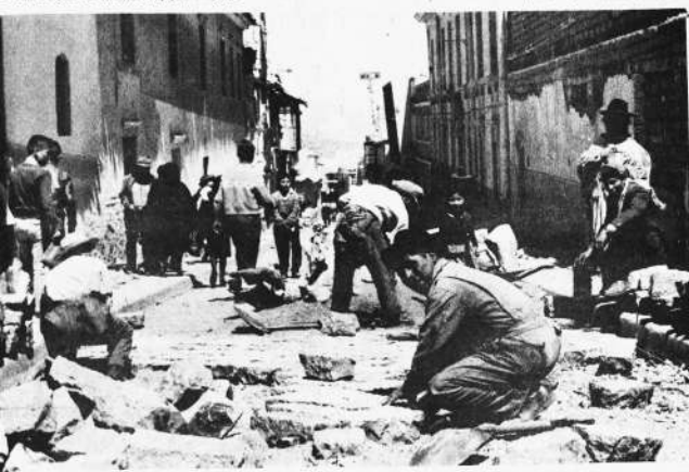
Grupo de obreros en plena trabajo de adoquinado en la Calle Bolívar.
