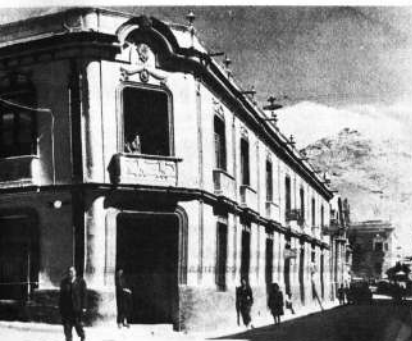
Edificio propio (Quintro esquina Motos) donde la Cámara Departamental de Minería tiene sus oficinas e instalaciones.
