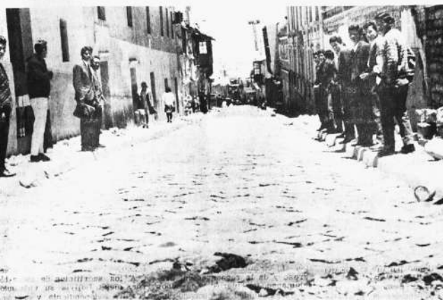
El trabajo de adoquinado de calles ha sido una de las obras importantes emprendidas por la Junta de Obras Públicas de Potosí. El grabado muestra una de las varias calles con pavimento nuevo.
