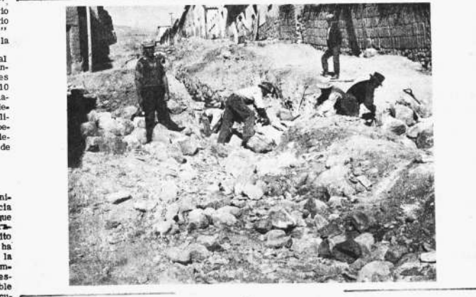
Son numerosas las cuadrillas de trabajadores que realizan febriles trabajos en diversas zonas, ya sea en trabajos de alcantarillado o adoquinado.
