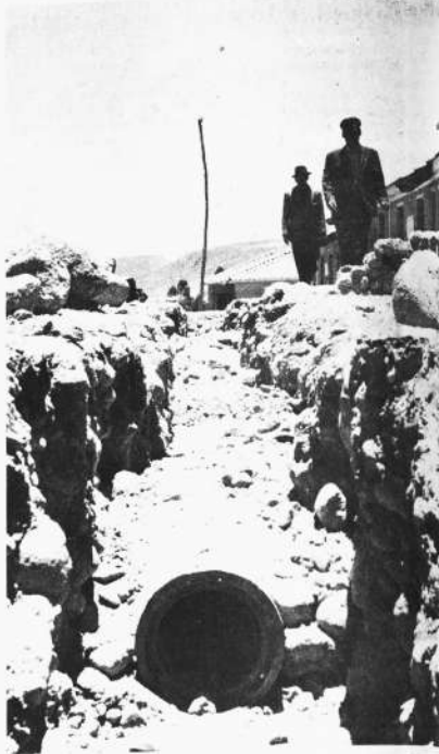
Trabajos de alcantarillado que se realizan en el Barrio de la zona norte. Las viviendas fueron construidas más de diez años y no contaban con este servicio.
