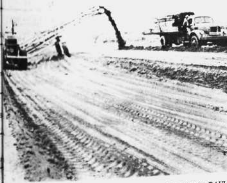
El equipo y maquinaria pesada de que dispone la empresa PAUL HARDEMAN, están distribuidos a lo largo de dos rutas donde 570 obreros dirigidos por quince técnicos bolivianos y extranjeros realizan una labor continua a través de 2 turnos para la conclusión de los proyectos 3 y 7.
