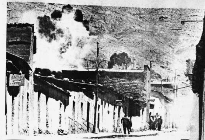
Las explosiones dinamiteras hicieron volar en pedruzcos muros, calaminas y ventanales. Sobre la calle Bolívar, perpendicular a la Campero, una fuerte explosión derribó el muro de la policía y mató a un carabiniere.
