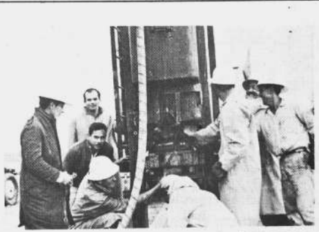
Grupo de obreros que opera el martinete impulsado por una compresora, que sirve para introducir en el suelo las planchas de acero que forman el rectángulo. Se coloca el enorme pilar o pila. El puente tendrá 14 pilares.
