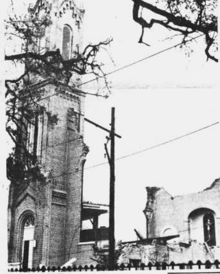
El barón Betsy que sembró desolación a lo largo de Louisiana y Mississippi, derribó esta Iglesia en Nueva Orleans, la Iglesia del Divino Redentor. El cuadro que presenta indudablemente la ciudad de Nueva Orleans es desolador en ciertos barrios. (AP Wirephoto)
