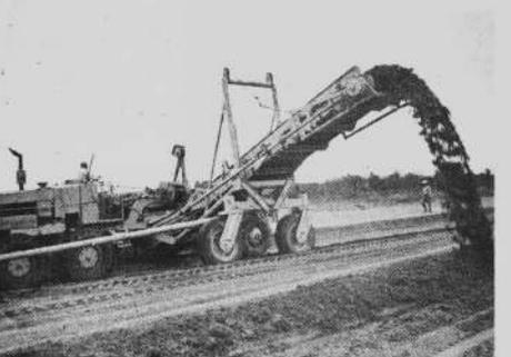
Una motoelevadora en pleno trabajo. Se trata de un equipo accionado por tractor y una correa transportadora. Con toda facilidad a medida que avanza la máquina saca la tierra de un lado y la transporta al centro de la vía. Este trabajo tiene que realizarse cuando la tierra tiene un cierto grado de humedad.
