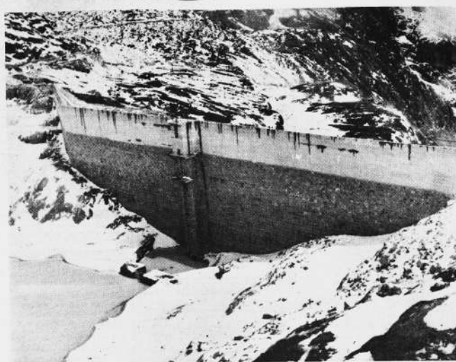
La represa de Zongo, tal como aparecía ayer, con apenas 60 centímetros de nivel. Contrariamente a la razón fundamental que venía dando la Power para justificar los racionamientos eléctricos, ayer sus personas dejaron de lado el problema de la escasez de agua en esa represa y afirmaron que la etapa crítica había pasado y que el racionamiento comenzaría a disminuir.
