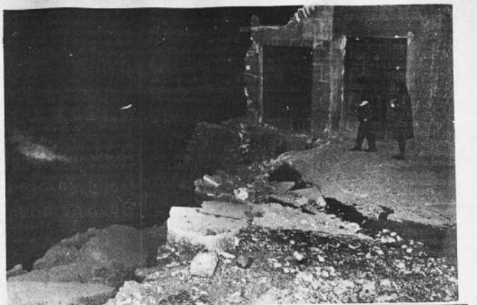
Paulatinamente se vienen registrando en la Avenida Buenos Aires nuevos deslizamientos de tierra como el ocurrido anoche a la altura del Puente Topáter. La residencia de las hermanas Guzmán es una de las más afectadas.
