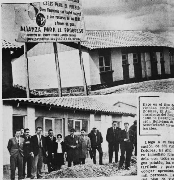
Durante la entrega de 102 casas construidas a las entidades financieras. En la foto personas de CONAVI, CBF, BID y de la empresa constructora Zuleta y Cia.
