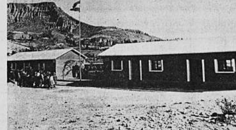
Vista de la escuela de Jumthuma. En primer término, el edificio de la vivienda del maestro y depósito. En segundo plano, el aula propiamente dicha.
