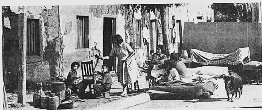
Las calles del pueblo de Llay Llay estuvieron atestadas de familias que, al iniciarse el temblor, abandonaron sus viviendas presas de pánico para protegerse de los derrumbes. Muchas perdieron sus casas y tuvieron que acomodarse en plena vía pública.
