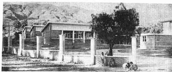
Entrada a las aulas y laboratorios
