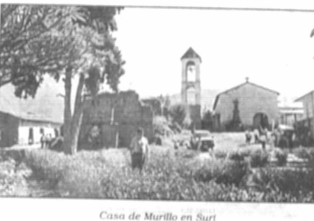
Casa de Murillo en Suri
